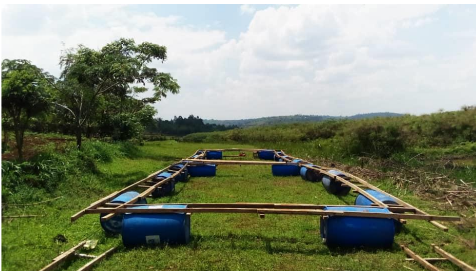
Assemblage, fixation des bidons sur le cadre en bois
