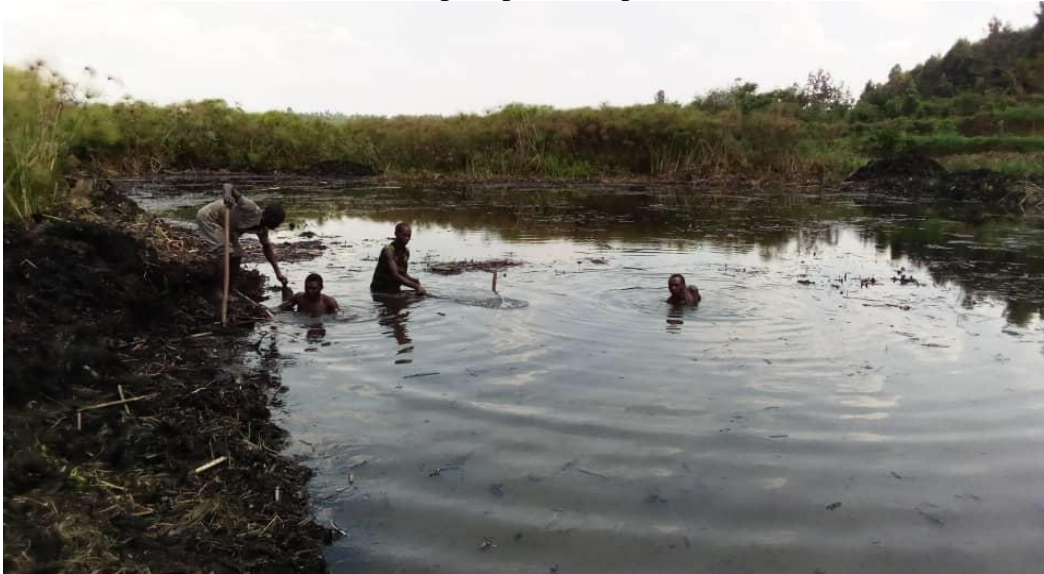
Décapage de différentes couches sous l'eau
